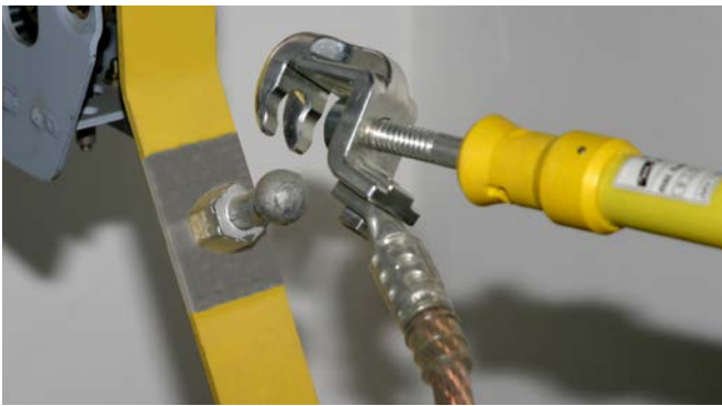
Phasenseitiger Anschluss der Universalklemme an einem Kugelfestpunkt.
