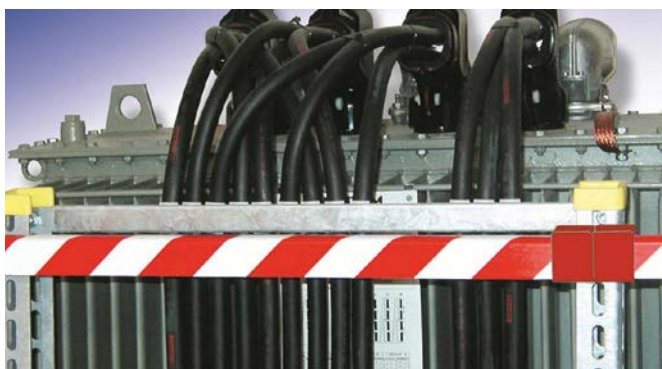
Absperrbalken montiert in Trafostation.
