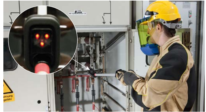
Spannungsprüfer PHG II an einer typgeprüften Schaltanlage.
