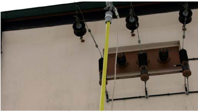
Teleskop-Erdungsstange mit Alu-Trichterkupplung und Phasenschraubklemme.
