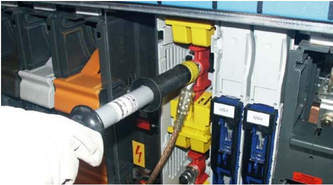
Einsetzen der teilisolierten Erdungs- und KurzschlieÙvorrichtung mit Hilfe des Erdungsgriffes TI.
