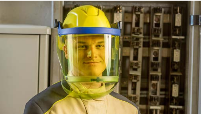
Monteur in einer Niederspannungsschaltanlage.
