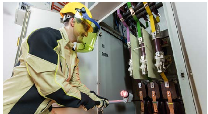
Spannungsprüfer PHE4 mit optischer und akustischer Anzeige.
