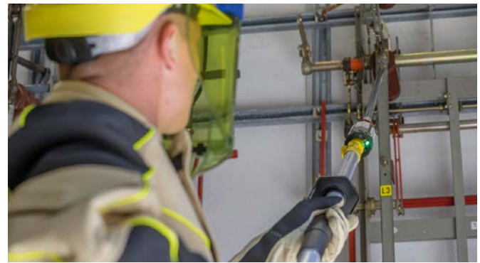
Spannungsprüfer PHE III mit optischer und akustischer Anzeige an einer Innenraumschaltanlage.
