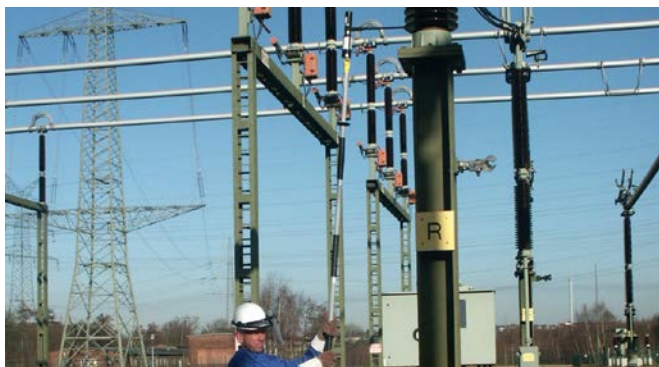
Abstands-Spannungsprüfer ASP in einer Freiluftschaltanlage.
