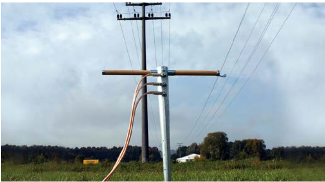
Erdungsrohr mit montierter Erdungsschiene und Erdungsseilen.
