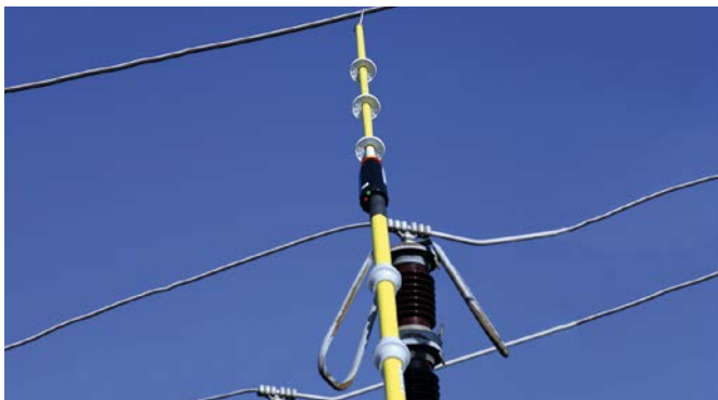
Spannungsprüfer PHE III an einer Freiluftstation 110 kV.
