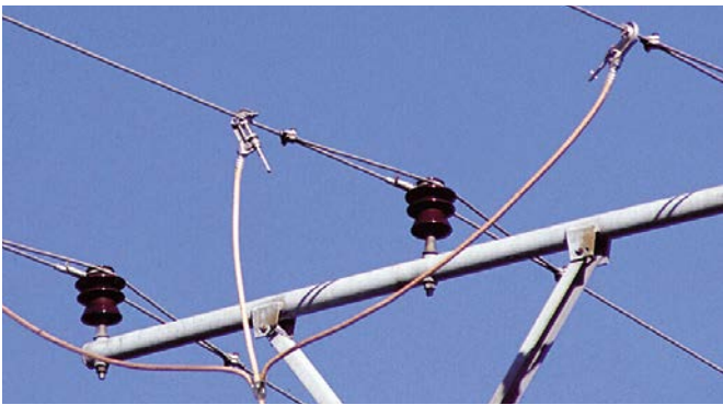
Phasenschraubklemmen in der Freileitung.
