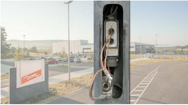
Erdungs- und KurzschlieÙvorrichtung an einem Übergangs- und Sicherungskasten eines Straßenbeleuchtungsmasten.
