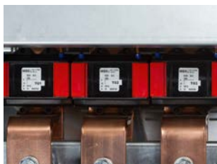
Eingebaute Schutzstromwandler
