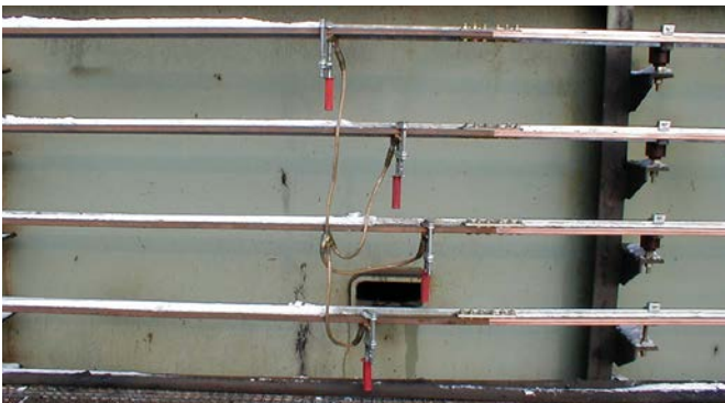
Dreipolige Erdungs- und KurzschlieÙvorrichtung mit Zwingenklemmen.
