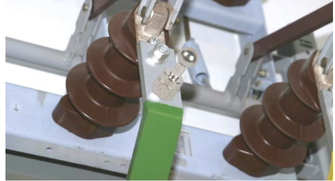
Kugelfestpunkt gerade, montiert auf einer Sammelschiene.
