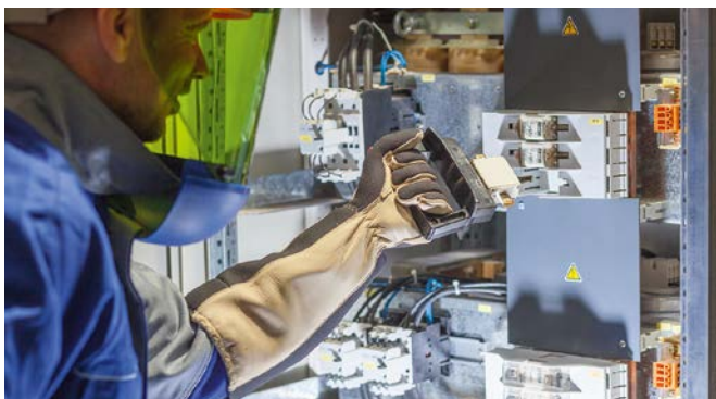
Betätigung eines NH-Aufsteckgriffes mit dem Schutzhandschuh.
