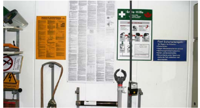
Warn- und Hinweisschilder in einer elektrischen Anlage.
