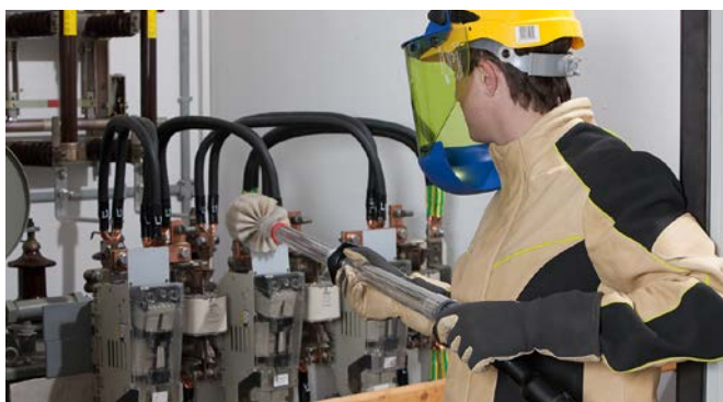
Reinigen eines Transformators mit dem Trockenreinigungsset TRS MS unter Spannung.
