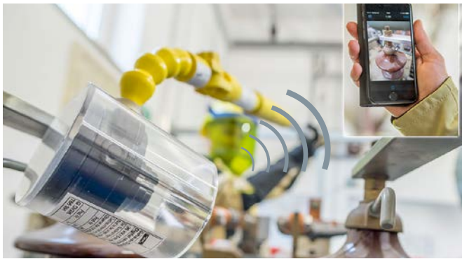
Rückseitige Kontrolle eines Isolators ohne Freischaltung.
