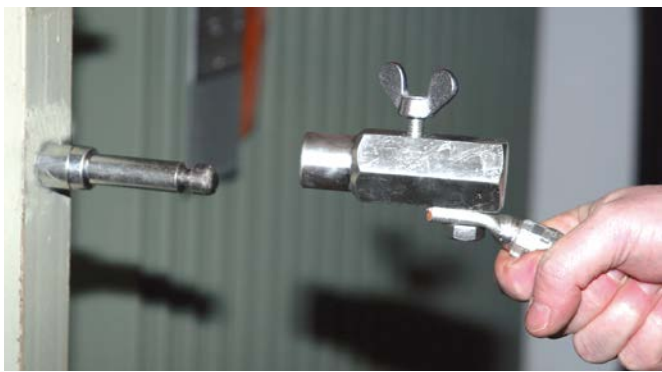
Erdungsfestpunkt mit Ringnut und Erdanschlussbuchse.
