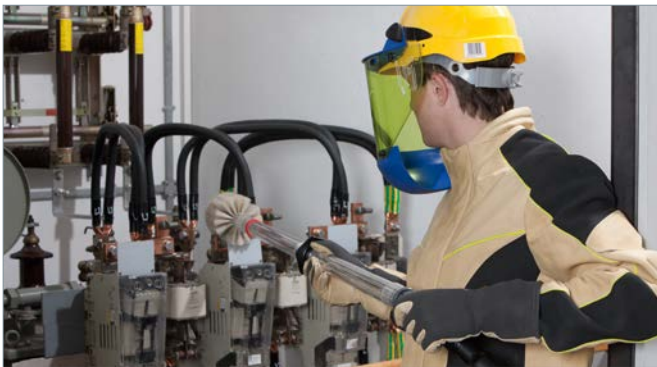
Im Vordergrund gereinigter Isolator.
