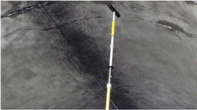
Entfernen von Eiszapfen an Tunnelleinfahrt.
