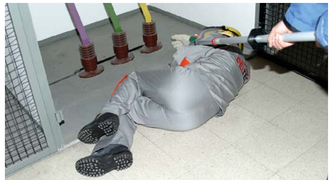
Rettung des Unfallopfers aus dem Gefahrenbereich mit Hilfe der isolierten Rettungsstange RST.
