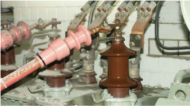
Im Vordergrund gereinigter Isolator.
