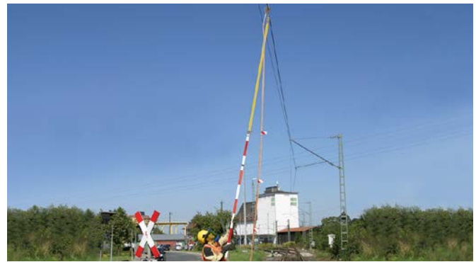
Einhängen einer Bahnerdungsvorrichtung.
