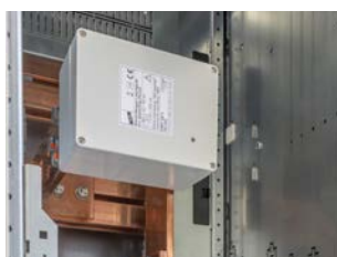
Löscheräte im eingebauten Zustand
