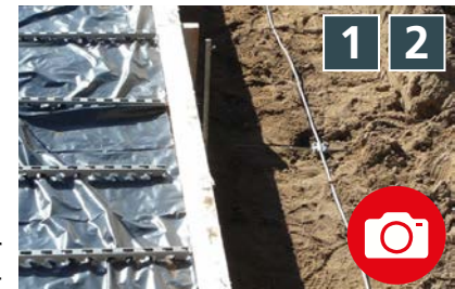
Ringerder neben der Bodenplatte eingebracht
