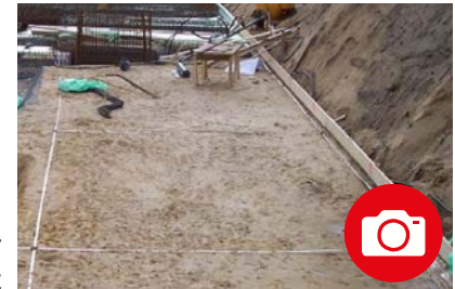
Vermaschter Ringerder unter der Bodenplatte eingebaut
